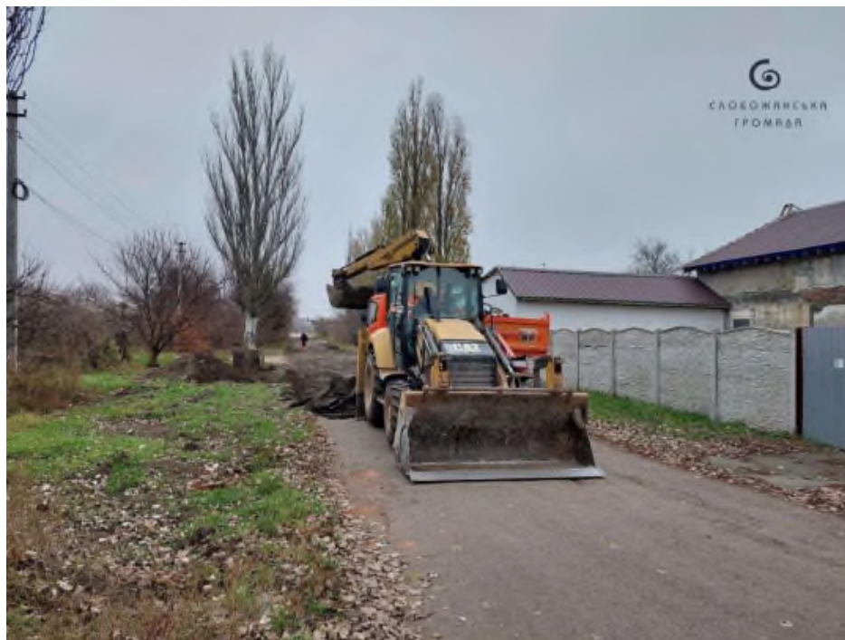
Під час ремонту по вул. Доновського.
